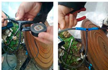
Изоляция места соединения датчика и ШС
